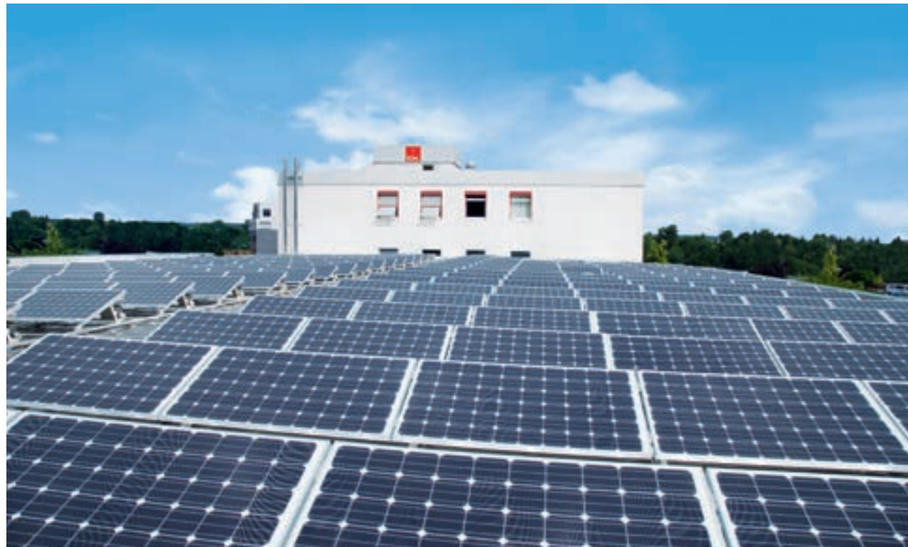
Saubere Solarenergie ist einer unserer Beiträge zu umweltgerechtem Handeln. Our contribution to a clean environment is our solar energy roof system.
